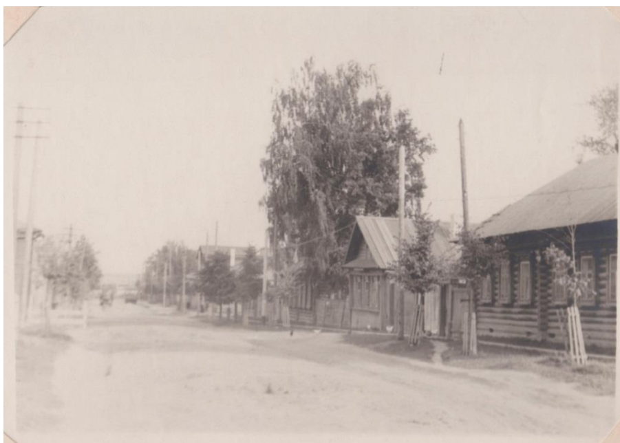
Рис. 15.5. – Йошкар-Ола. Ул. Рождественская (Новопокровская) 449 . Фотография. 1960 г.
