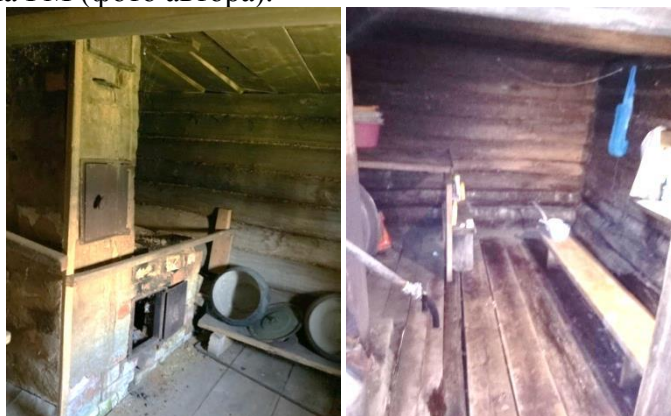
Фото 64, 65. Печь и внутреннее устройство бани «по-белому» // ПМА – июль 2020 г., эрзя-мордовская д. Ташто Кшуманца Большеигнатовского района РМ (фото автора).
