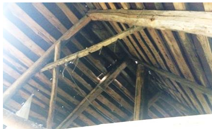
Фото 29. Стропильная конструкция крыши // ПМА – июнь 2018 г., эрзя-мордовская д. Петровка Большеигнатовского района РМ (фото автора).
