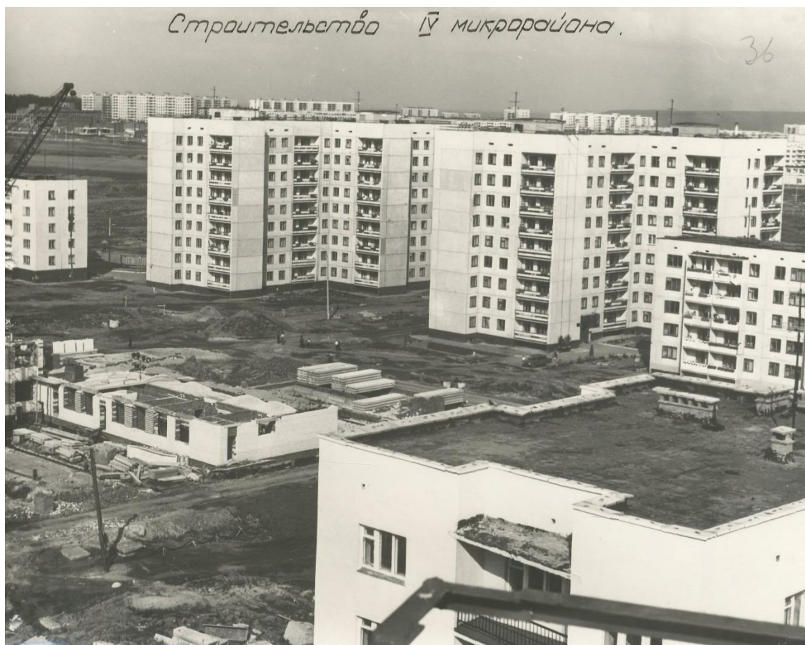
Фото 12: Строительство IV микрорайона г. Новочебоксарска 446
